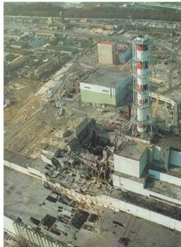
Разрушенный энергоблок Чернобыльской АЭС
