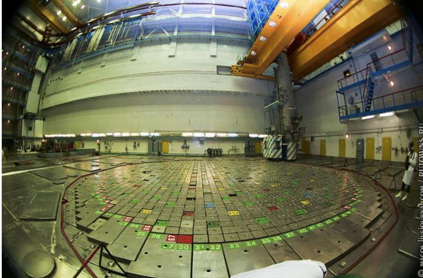
«Сердце» атомной станции - центральный зал. Под этими кубиками находится атомный реактор РБМК-1000 (точно такой же, как на ЧАЭС).
